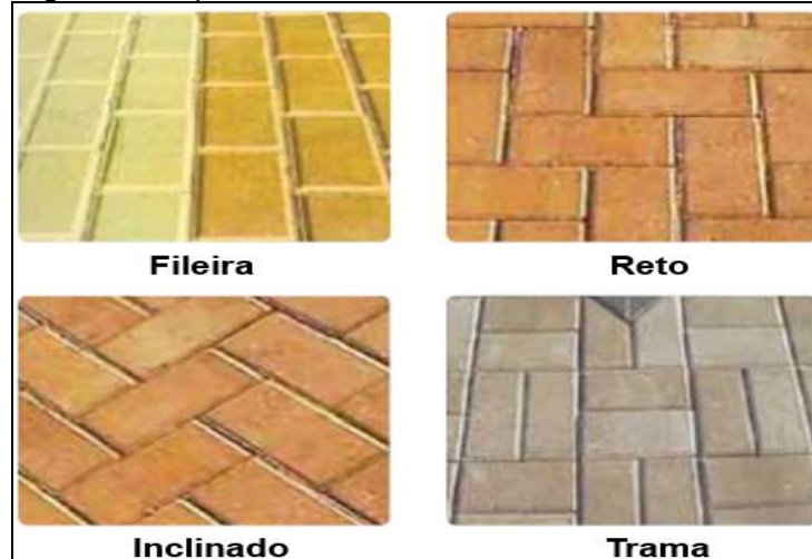
Figura 10 - Tipos de assentamento dos blocos intertravados
