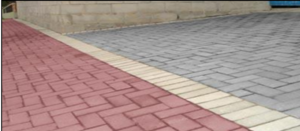
Figura 3 - Exemplo de pavimento de concreto intertravado
