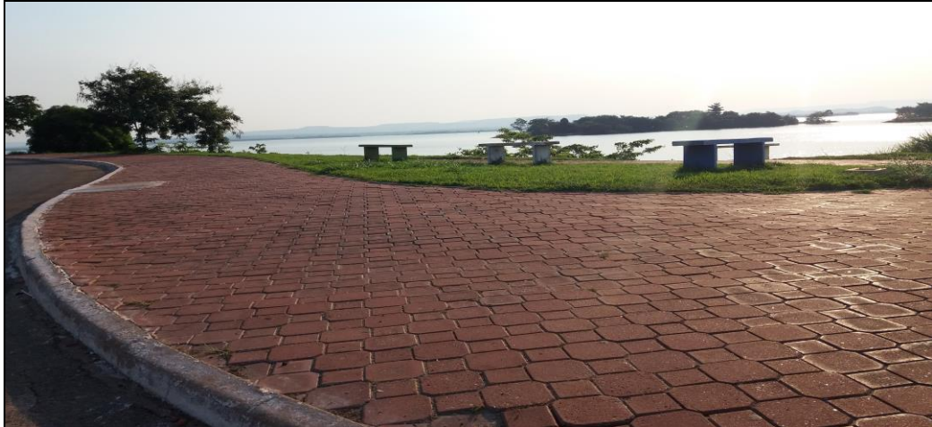
Figura 5 - Orla de Porto Nacional - TO, com a utilização de blocos intertravados
