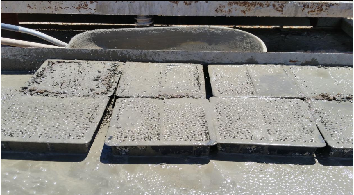
Figura 18 - Fabricação dos blocos de concreto ocorreu em uma máquina vibroprensa semiautomática pneumática
