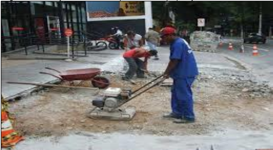
Figura 14 - Utilização da bica corrida para a fase de preparação da base
